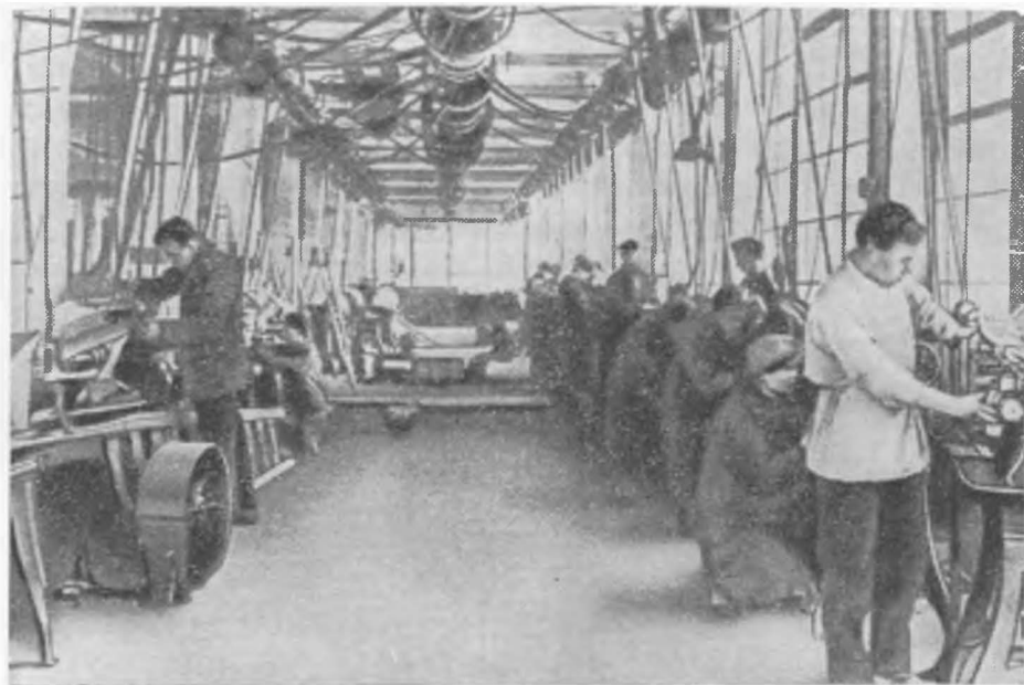
Монтаж оборудования на 2-м часовом заводе. 1930 год
